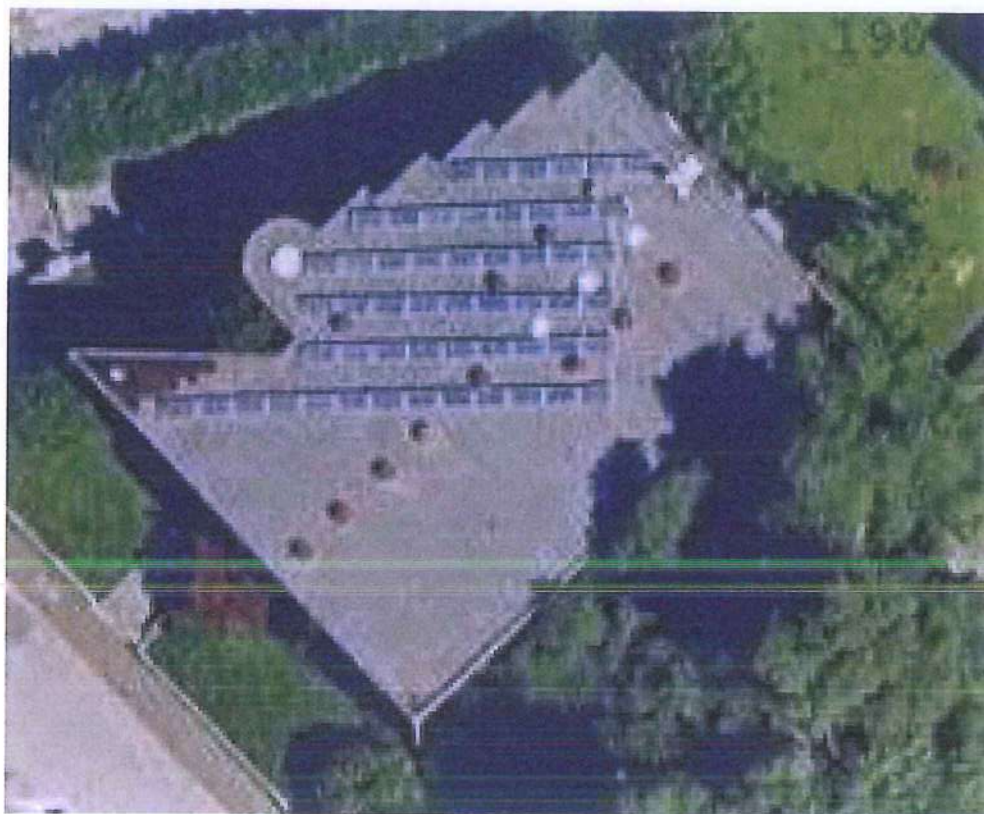
Impianto fotovoltaico sulla copertura
